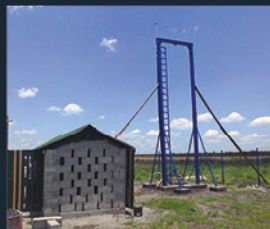
Station Pompage d'eau - Congo
