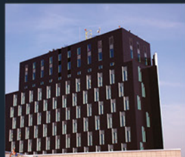
Centre administratif Roumanie
